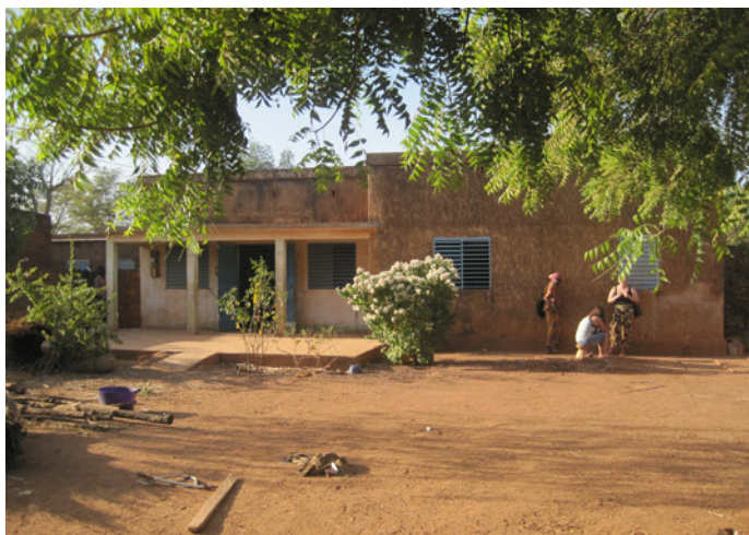
Vorderansicht des Wohnhauses
