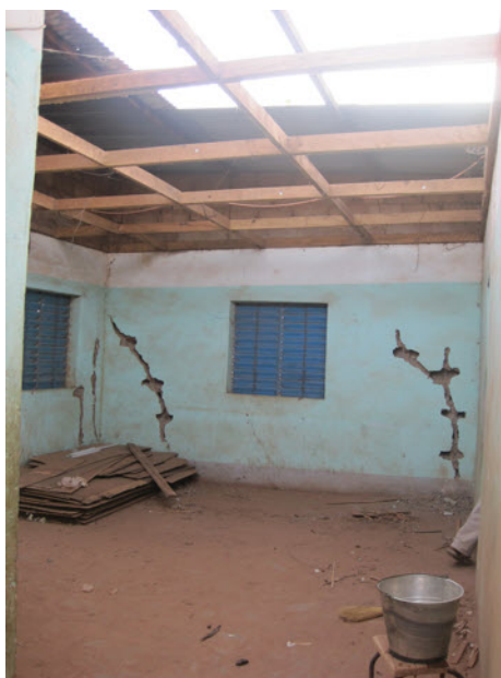
Die Erneuerung des Daches und der Wände im Wohnzimmer
