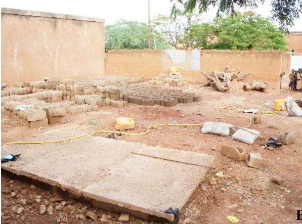
Erste Bilder der Baustelle...
